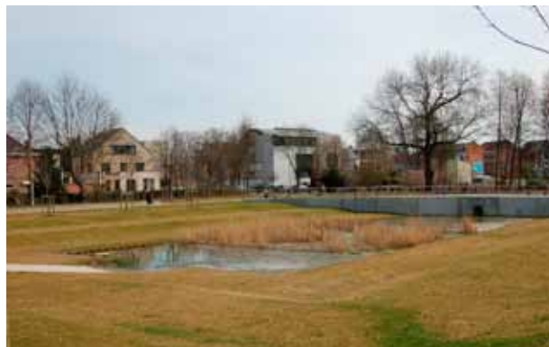
De terrassen zijn met gras beplant en doen dienst als ligweide wanneer het water in het bufferbekken laag staat.
